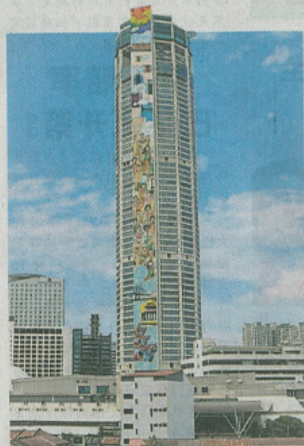
一旦光大摩天楼壁画完成，有望打入《健力士世界纪录大全》世界最高壁画宝座。
